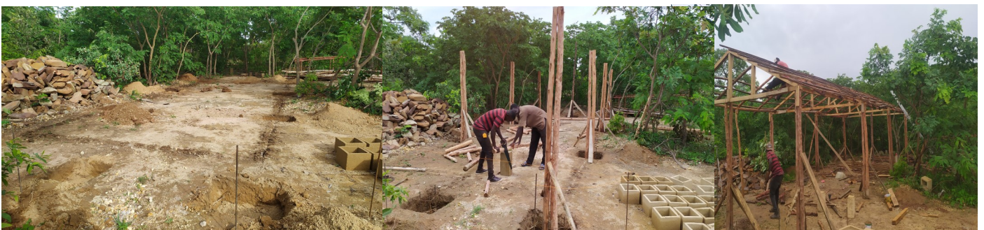
« Die Schmitte » für das Kinderprogramm (Wiederverwertung vom Baustellenmaterial )
