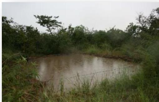
*Nouveau bassin de collecte d'eau rempli dès la première pluie tombée après un travail le décapage de la partie argileuse du sol. Le fond est une pierre latérite dure à creuser pour gagner en profondeur afin de retenir le maximum d'eau. Travaux à venir,*
