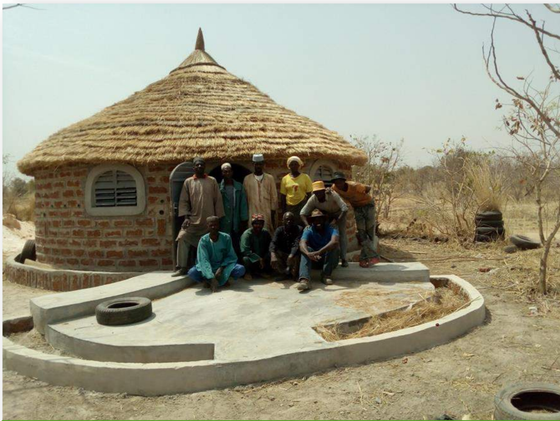
Le logement du gardien réalisé à 90 pour cent de matériaux locaux, renouvelable et recyclés. 1800.-
