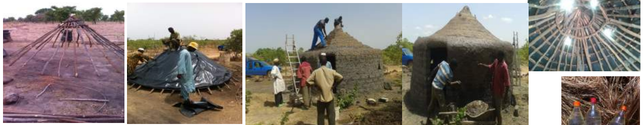
Un logement à presque 100% fait de matériaux locaux. Eclairage avec des bouteilles PET, de l'eau et de l'eau de javel.
