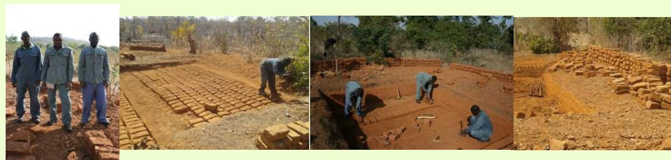
En avant pour l'extraction de briques en pierre de latérite, matériaux de construction présent sur le site, utilisés pour les ouvrages dans la ferme. Les bassins de l'extraction deviennent des réservoirs de collecte d'eau de pluies.
