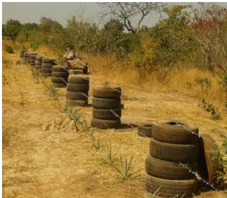
Travaux de clôture avec des pneus usagés.
