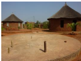
Au fond une plateforme et une case à droite inachevées. Devant une plateforme inachevée.
